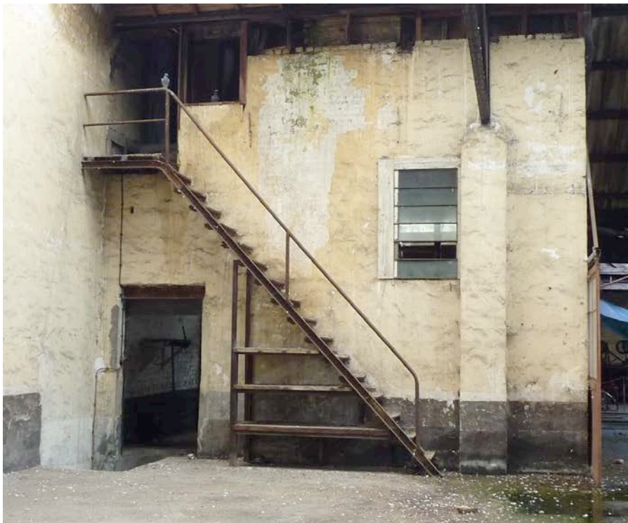
Figuur 5: De trap naar de verdieping van het atelier.
