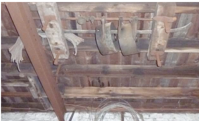
Figuur 8: Stockage van aandrijfwielen e.d. tegen het plafond in atelier 00.14
