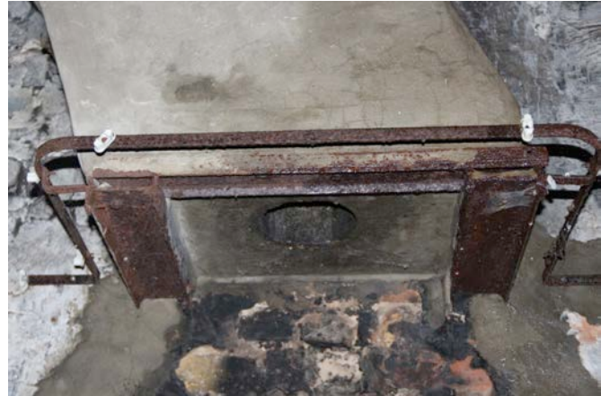
Figuur 17: Detail profielen onderaan schouwkanaal.
