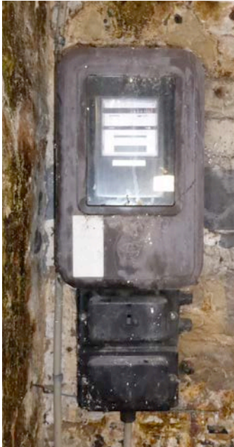
Figuur 14: Elektricietsmeter naast deur naar atelier. Figuur 15: Aftakdoos in atelier.
