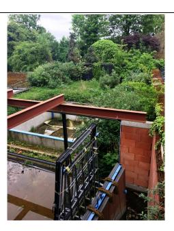
Des poutres maîtresses sont incorporées aux appuis sans asselet ou sont insuffisamment resserrées. Des linteaux sont incomplets et épaufrés.
