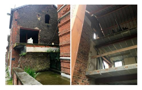
Les poutres de baie arrière ainsi que de la grande baie latérale droite ne reprennent pas la totalité de la maçonnerie et ne sont pas asservies ensemble.
