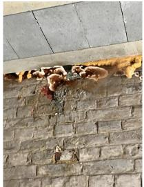
La baie principale de façade arrière a été exécutée sans prendre les précautions nécessaires en terme d'exécution et de dimensionnement (et au niveau des appuis). La maçonnerie présente des dégradations et une fissuration aux différents appuis ainsi que dans les trumeaux du rez de chaussée (fissures, tassements).
