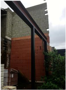
Maçonnerie du rez de chaussée du corps principal : la maçonnerie au rez de chaussée et en cave présente une humidité relative située entre 28 et 63 grades avec un testeur GEO avec des points plus humides identifés. Compte tenu de la présence d'eau, il ne peut être écarté la possibilité d'implantation de champignons en caves.
