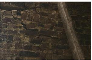
Plusieurs zones de poutrains-claveaux sont exécutées avec des porte-à-faux que les poutrains ne peuvent reprendre.
