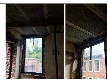
Les maçonneries du 1<sup>er</sup> étage présentent à proximité d'une baie du pignon d'entrefin, une implantation de mérule qui a traversé l'épaisseur de la maçonnerie.
