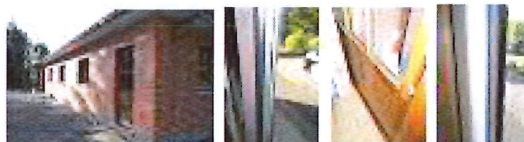
Vue façade arrière
