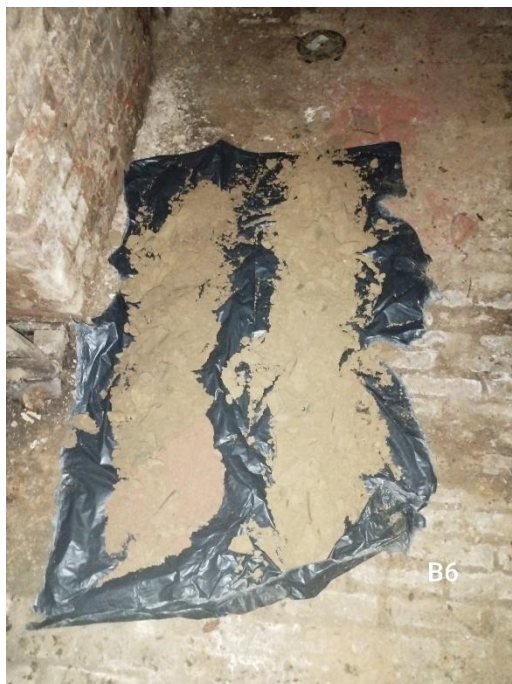
Photo 3 : vue du forage B6
