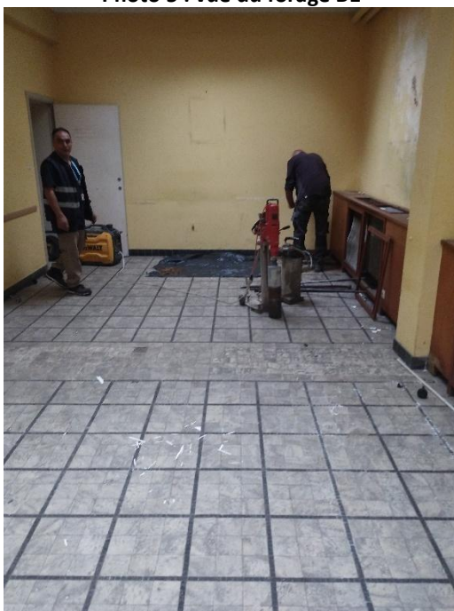
Photo 6 : vue de l'emplacement du forage B1
