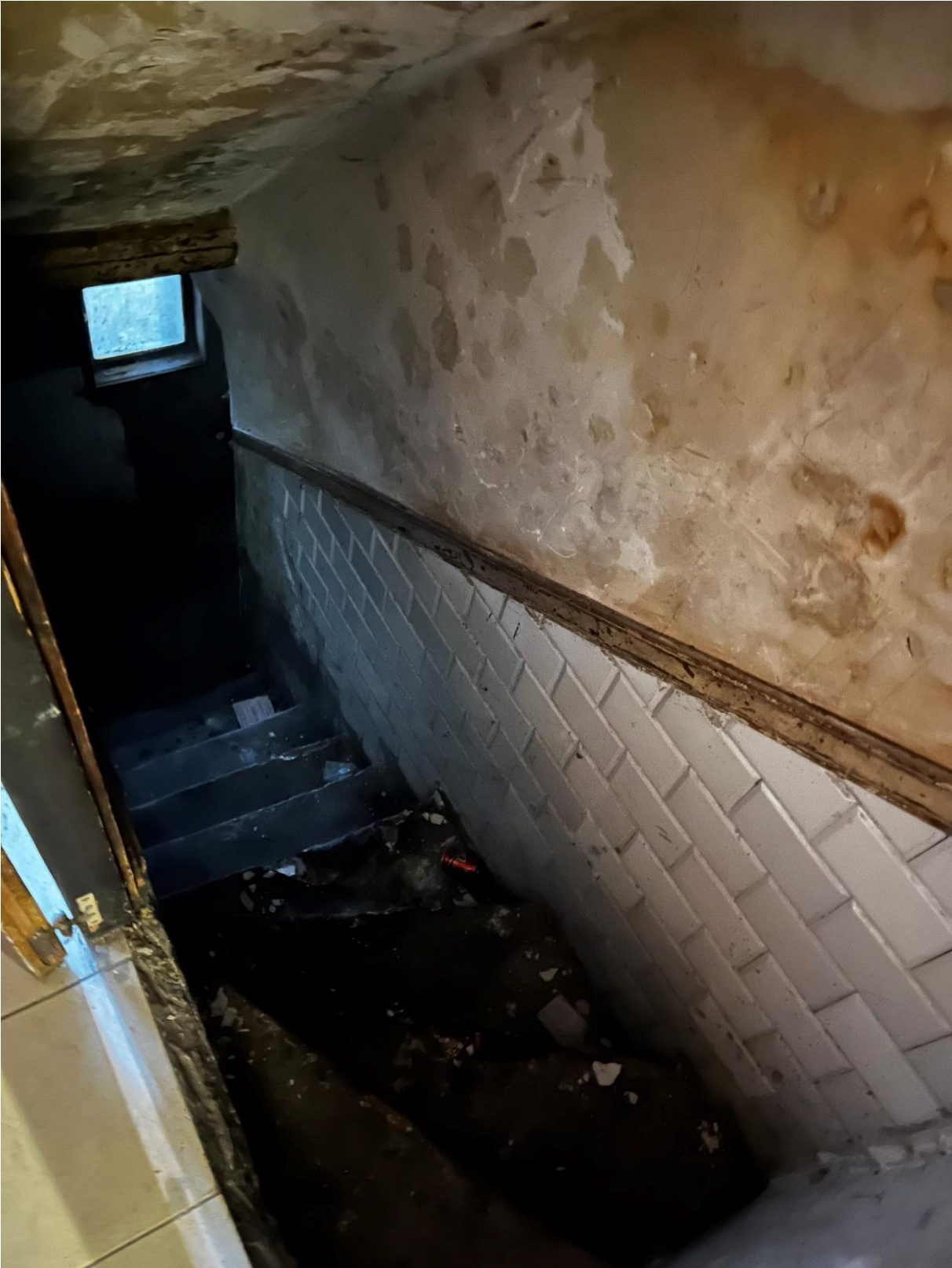
Escaliers menant vers les caves
