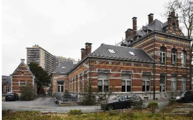
Veeartsenstraat 45-47, voormalige Staatsveeartsenijschool, centraal lesgebouw, achtergevel en linker zijgevel, (© ARCHistory, 2019)
