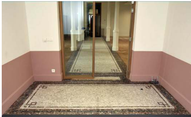
Veeartsenstraat 45-47, voormalige Staatsveeartsenijschool, administratief gebouw, eerste verdieping, voormalige kantoren, (© ARCHistory, 2019)
