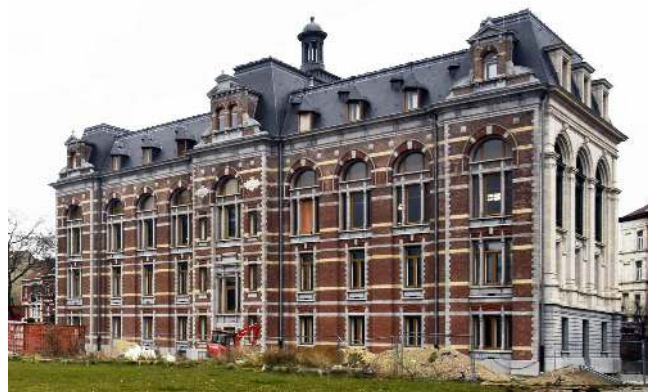
Veeartsenstraat 45-47, voormalige Staatsveeartsenijschool, administratief gebouw, achtergevel, (© ARCHistory, 2019)
