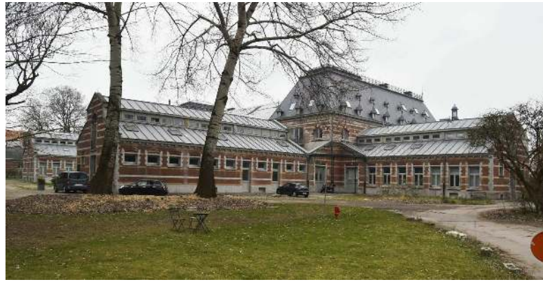
Veeartsenstraat 45-47, voormalige Staatsveeartsenijschool, de grote Kliniek vanuit het zuiden, (© ARCHistory, 2019)
