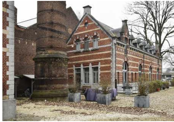
Veeartsenstraat 45-47, voormalige Staatsveeartsenijschool, machinegebouw, rechter gebouw, (© ARCHistory, 2019)
