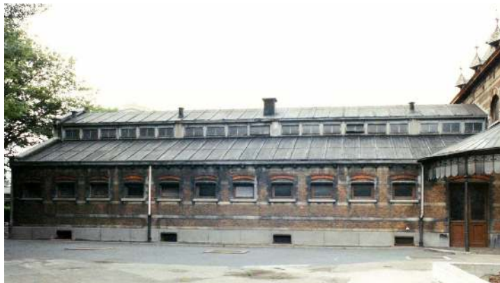
Veeartsenstraat 45-47, voormalige Staatsveeartsenijschool, de grote Kliniek, zuidelijke volume achteraan, voor de vervanging van de vensters, Archives CRMS, AND200317 © urban.brussels
