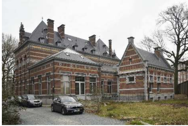
Veeartsenstraat 45-47, voormalige Staatsveeartsenijschool, linker lesgebouw, achtergevels, (© ARCHistory, 2019)
