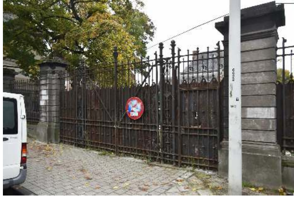
Veeartsenstraat 45-47, voormalige Staatsveeartsenijschool, hekwerk inkom, (© ARCHistory, 2019)
