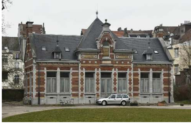
Veeartsenstraat 45-47, voormalige Staatsveeartsenijschool, het kleine kliniek, voorgevel, (© ARCHistory, 2019)
