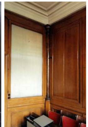
Veeartsenstraat 45-47, voormalige Staatsveeartsenijschool, administratief gebouw, eerste verdieping, detail van een kantoor, Archives CRMS, AND200317 © urban.brussels
