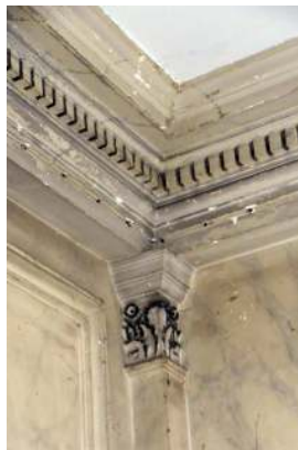
Veeartsenstraat 45-47, voormalige Staatsveeartsenijschool, administratief gebouw, benedenverdieping, detail in de hal, (© ARCHistory, 2019)
