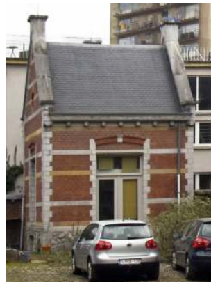
Veeartsenstraat 45-47, voormalige Staatsveeartsenijschool, maceratiepaviljoen, (© ARCHistory, 2019)
