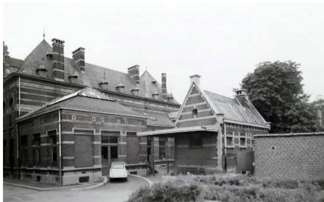
Veeartsenstraat 45-47, Staatsveeartsenijschool, linker lesgebouw, achtergevels, 1967, GAA/DS 42908 (15.12.1967)
