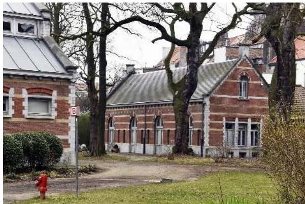
Veeartsenstraat 45-47, voormalige Staatsveeartsenijschool, smederij vanuit het noorden, (© ARCHistory, 2019)
