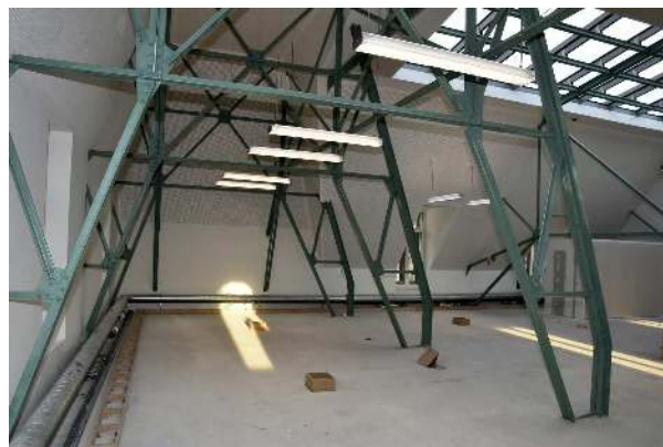
Veeartsenstraat 45-47, voormalige Staatsveeartsenijschool, administratief gebouw, detail van het gebinte, (© ARCHistory, 2019)
