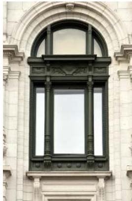
Veeartsenstraat 45-47, voormalige Staatsveeartsenijschool, administratief gebouw, centrale travee, venster op de tweede verdieping, (© ARCHistory, 2019)
