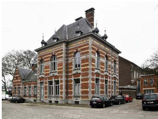
Veeartsenstraat 49, voormalige Staatsveeartsenijschool, dienst Entstoffen, voorgevel en rechter zijgevel, (© ARCHistory, 2019)
