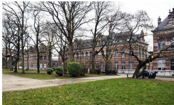
Veeartsenstraat 45-47, voormalige Staatsveeartsenijschool, lesgebouwen vanuit het noorden, (© ARCHistory, 2019)
