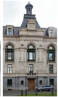
Veeartsenstraat 45-47, voormalige Staatsveeartsenijschool, administratief gebouw, centrale travée, (© ARCHistory, 2019)
