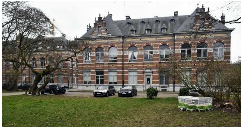
Veeartsenstraat 45-47, voormalige Staatsveeartsenijschool, rechter lesgebouw, (© ARCHistory, 2019)
