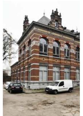
Veeartsenstraat 45-47, voormalige Staatsveeartsenijschool, linker lesgebouw, linker hoek, (© ARCHistory, 2019)
