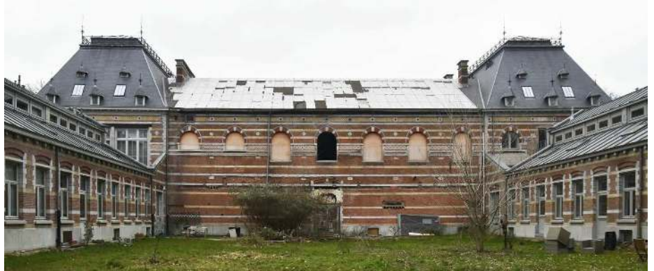
Veeartsenstraat 45-47, voormalige Staatsveeartsenijschool, de grote Kliniek, achtergevel, (© ARCHistory, 2019)
