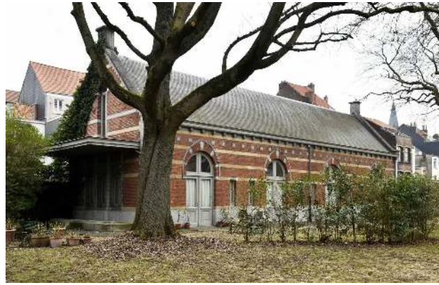
Veeartsenstraat 45-47, voormalige Staatsveeartsenijschool, smederij vanuit het zuiden, (© ARCHistory, 2019)
