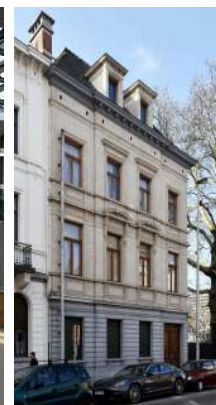
Veeartsenstraat 45-47, voormalige Staatsveeartsenijschool, directeurswoning, (© ARCHistory, 2019)
