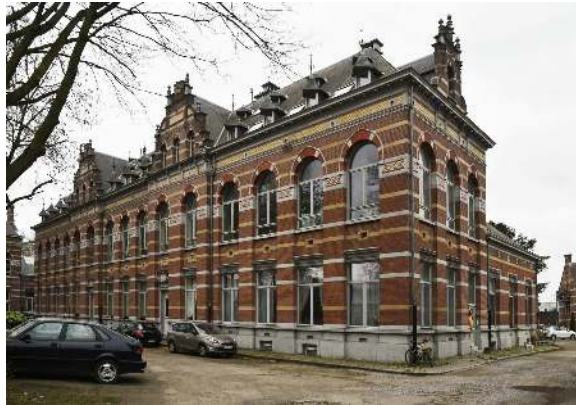
Veeartsenstraat 45-47, voormalige Staatsveeartsenijschool, centraal lesgebouw, voorgevel, (© ARCHistory, 2019)
