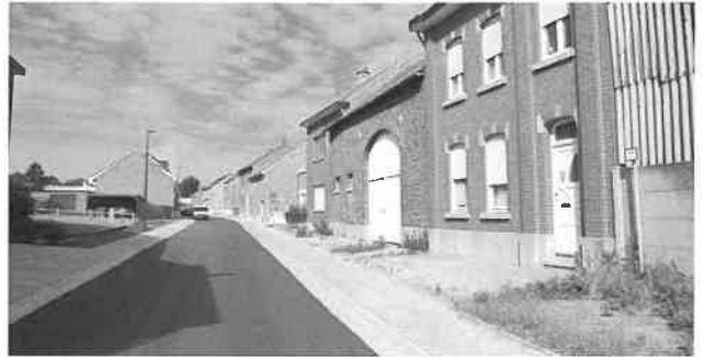
Recente heraanleg 3de Regt. Lanssiersstraat (boven) en oorspronkelijke aanleg (onder)
