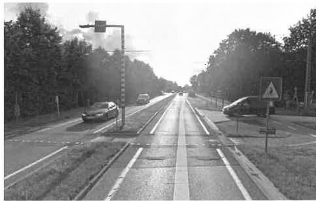
Oversteekplaats met wachteiland langs R25 in Aarschot (google streetview)
