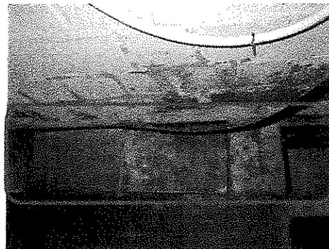
Nous avons réalisé l'endoscopie de ce caniveau d'égouttage => aucune cassure franche n'est constatée sur ce caniveau.
