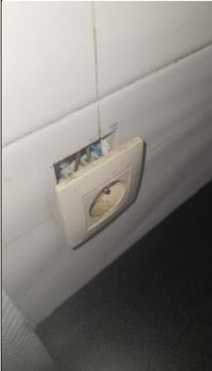
4.2.2.1\_ Présence de possibilité de contacts directs (pièces nues sous tension) au niveau des prises de courant
