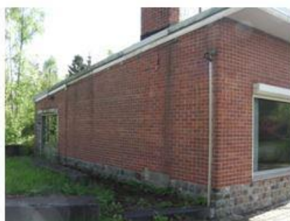
Angle sud ouest
