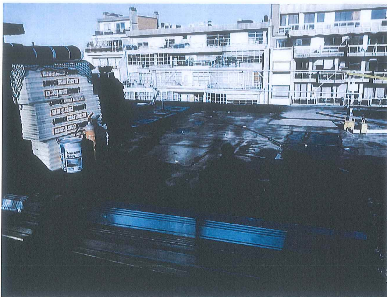
PHOTO DURANT LES TRAVAUX
