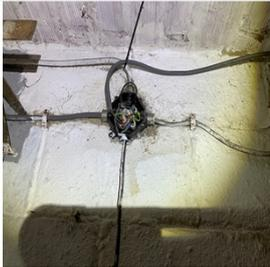
– La correspondance entre les degrés de protection (IP) du matériel électrique contre les contacts directs et les volumes dans la salle de bain n'est pas respectée. (7.1.4.3.)
