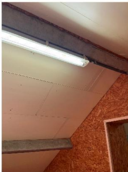
isolation toiture xps
