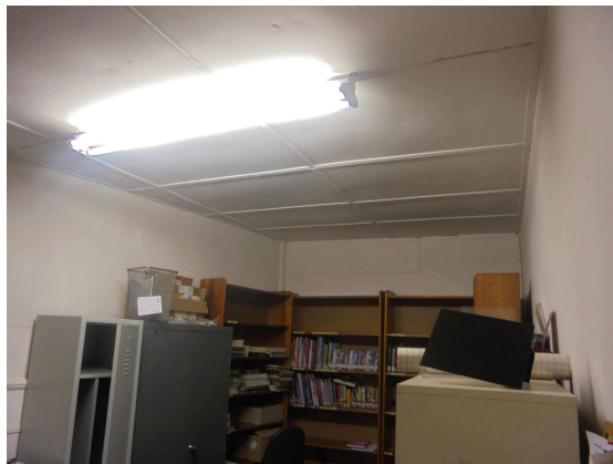
Afbeelding 3. Plafondafwerking met niet-verdachte platen.
