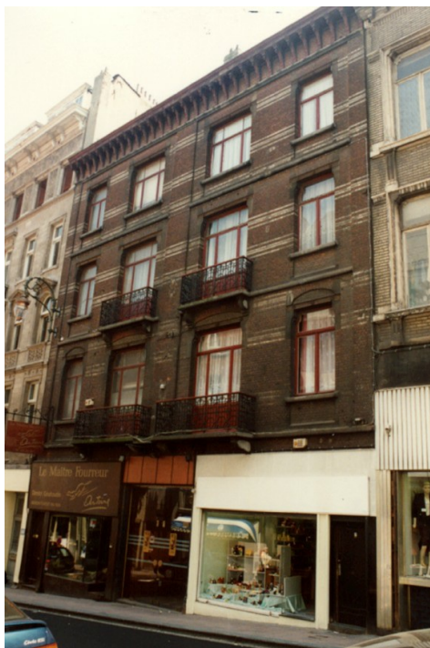
Chaussée de Louvain 20-28, Cabaret Claridge (photo 1993-1995)
