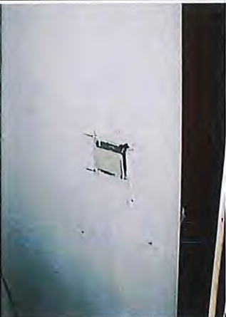
Foto 47: Ontbrekende afdekplaatjes
