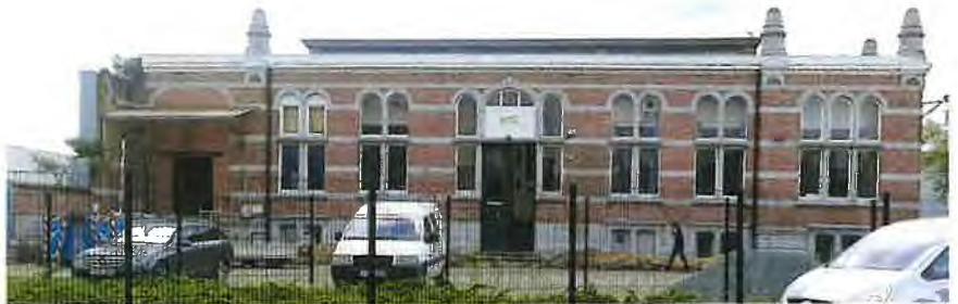
Rue des Deux Gares 128, gare de la Petite-Ile, 2016
