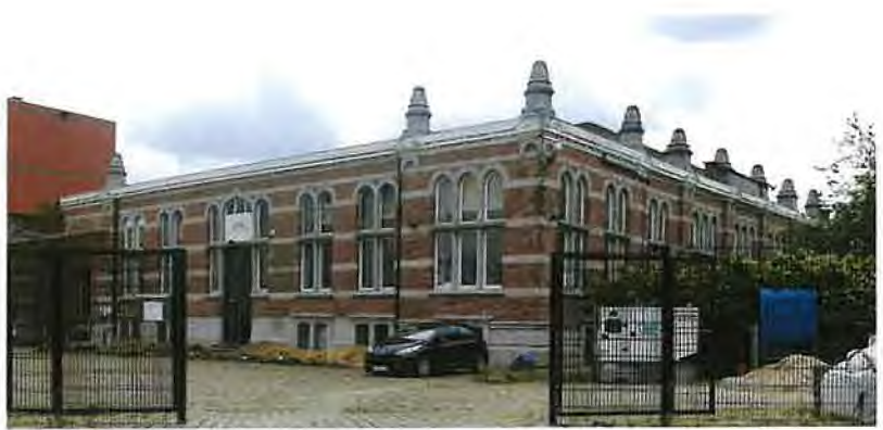
Rue des Deux Gares 128, gare de la Petite-Ile, 2016
