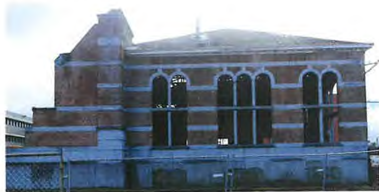
Rue des Deux Gares 128, gare de la Petite-Île, 2016
