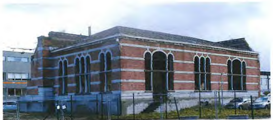
Rue des Deux Gares 128, gare de la Petite-Île, 2016
