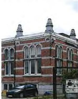
Rue des Deux Gares 128, gare de la Petite-Ile, 2016
