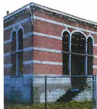
Rue des Deux Gares 128, gare de la Petite-Île, 2016
