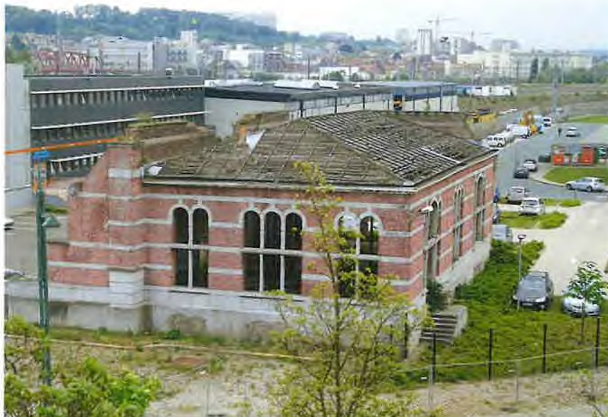
Rue des Deux Gares 128, gare de la Petite-Ile, 2016
