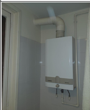
Foto 16: wandketel type B aangesloten
