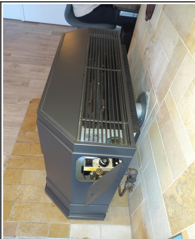
Foto 20: gaskachel woonkamer type B aangesloten
