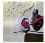
Il manque des rosaces derrière les prises et/ou interrupteurs en nécessitant. (1.4.)
