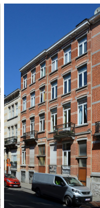
Rue du Transvaal 16 et 18, (© ARCHistory, 2019)
