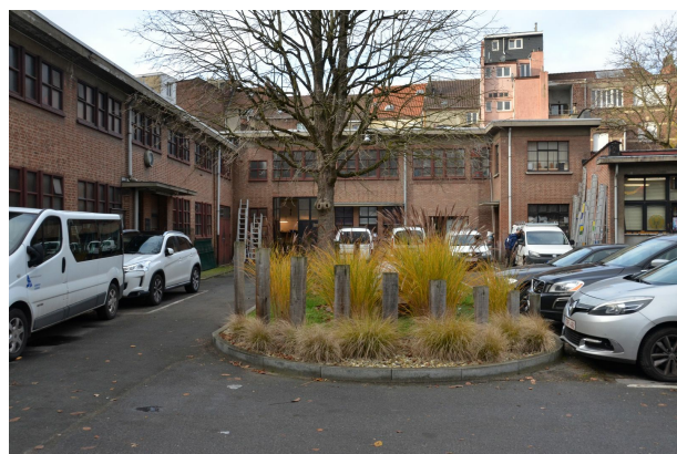
Rue du Transvaal 21, vue du complexe en intérieur d'îlot, (© ARCHistory, 2019)
