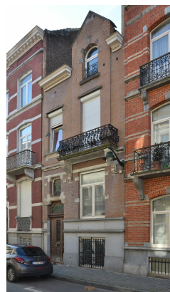
Rue du Transvaal 9, (© ARCHistory, 2019)
