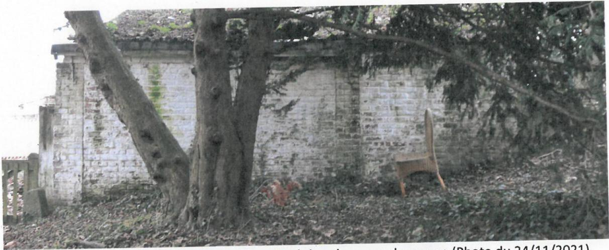
Absence de gouttières et installation d'humidité dans les murs du garage (Photo du 24/11/2021)
