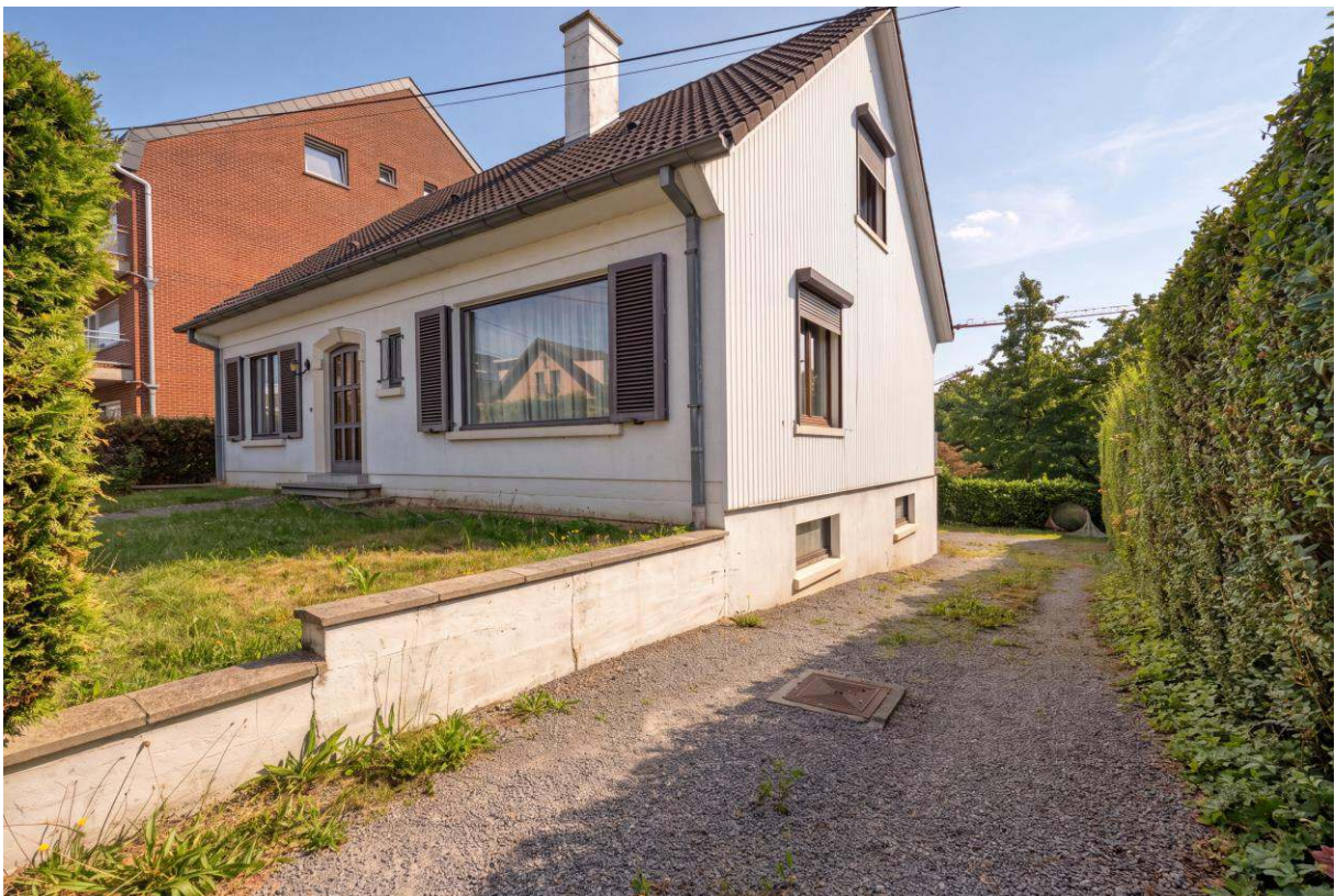
Photo de la façade
