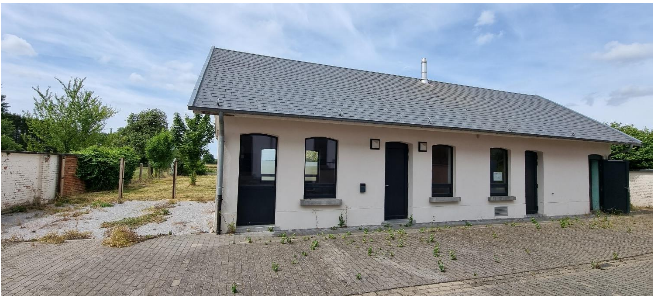
Photo 2 (Descente en fibrociment éliminée)
