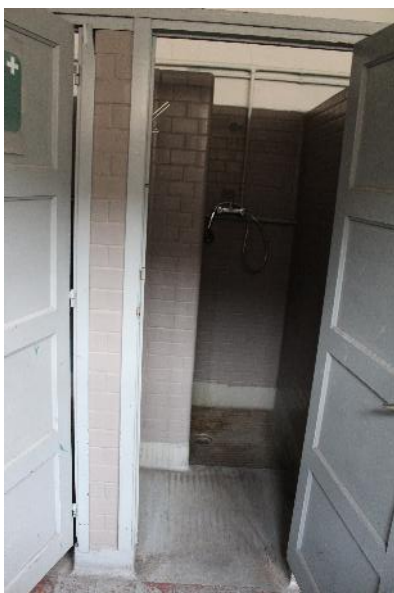
Rue Léon Delacroix 26-28, photo des sanitaires, 2026.
