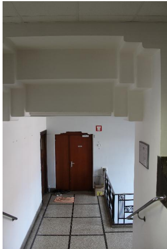
Léon Delacroixstraat 26-28, foto trappenhuis, 2026.
