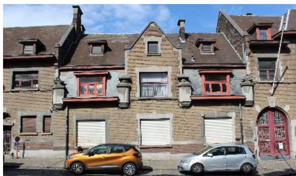
Rue Léon Delacroix 26-28, photo de la façade des bureaux, 2026.
