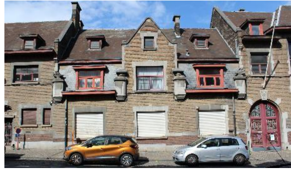
Léon Delacroixstraat 26-28, foto gevel burelen, 2026.
