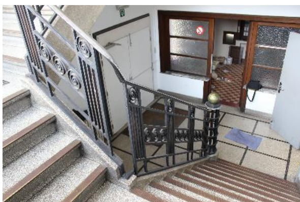
Léon Delacroixstraat 26-28, foto trappenhuis, 2026.
