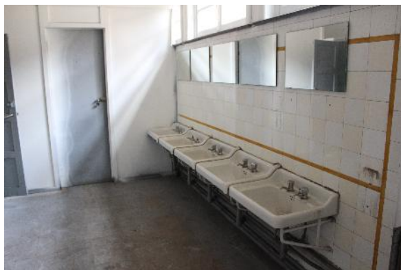
Rue Léon Delacroix 26-28, photo des sanitaires, 2026.
