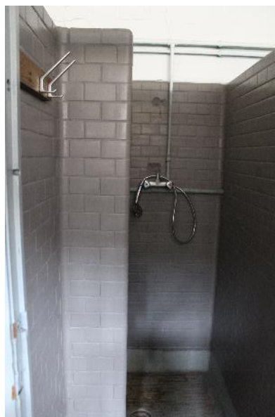
Rue Léon Delacroix 26-28, photo des sanitaires, 2026.
