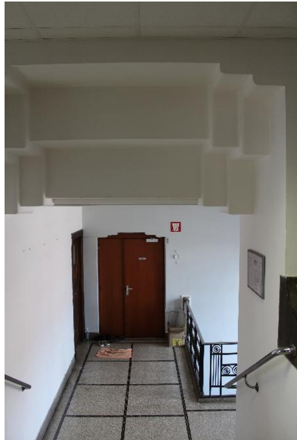
Rue Léon Delacroix 26-28, photo de la cage d'escalier, 2026.
