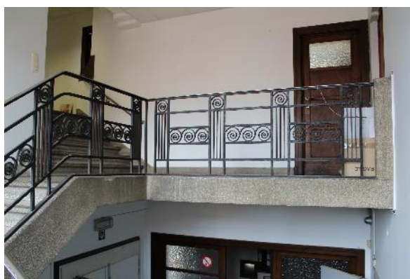
Léon Delacroixstraat 26-28, foto trappenhuis, 2026.
