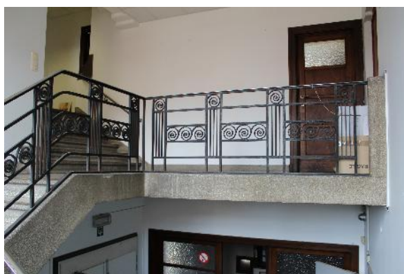
Rue Léon Delacroix 26-28, photo de la cage d'escalier, 2026.
