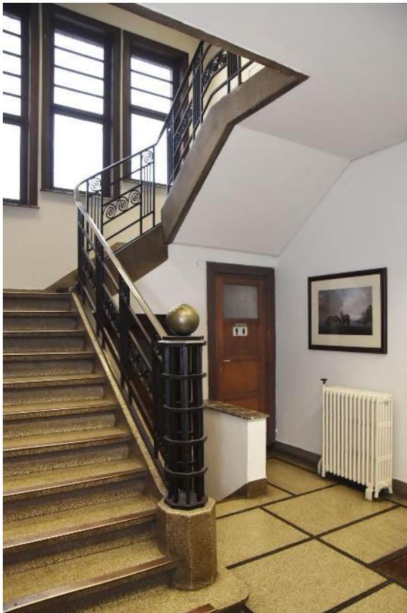
Léon Delacroixstraat 26-28, foto trappenhuis, 2026.
