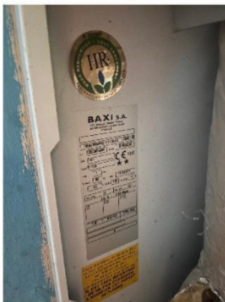
chaudière gaz atmosphérique
