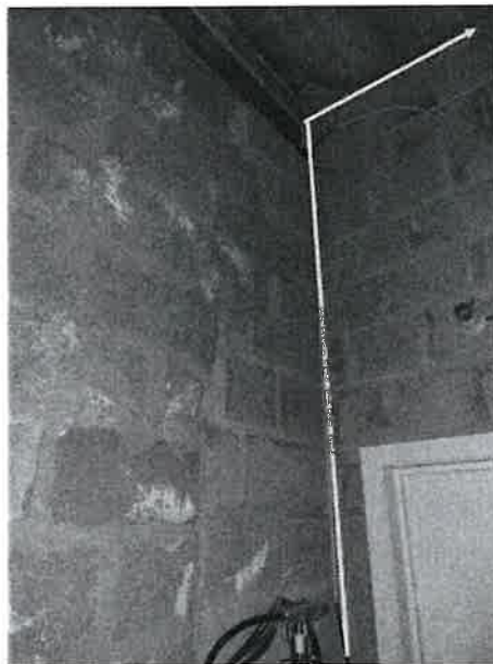
BLOC C RDC BDFO vers LU's
