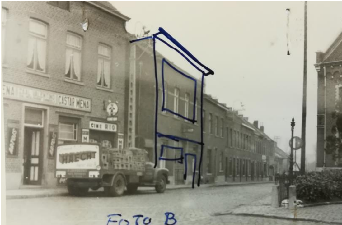
Zicht op de voormalige bebouwing t.h.v. Gemeenteplein 5.
