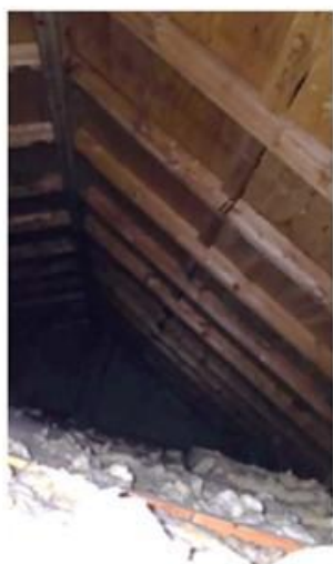
Isolant plafond vers comble
