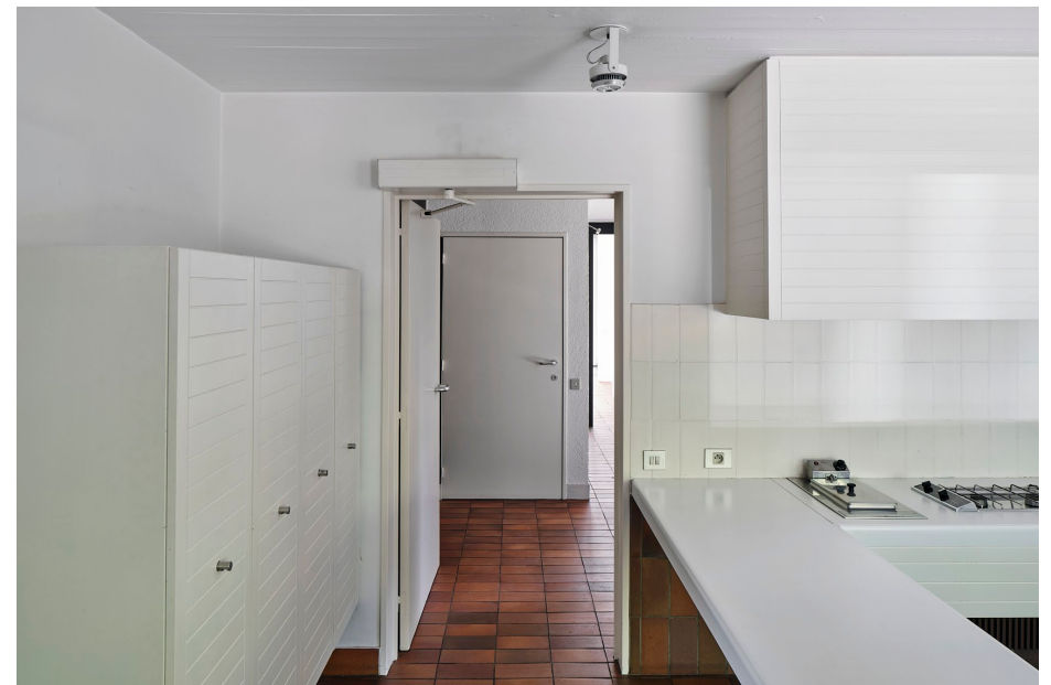
^ Brede geautomatiseerde doorgangen tussen de leefruimtes, inkom en keuken
