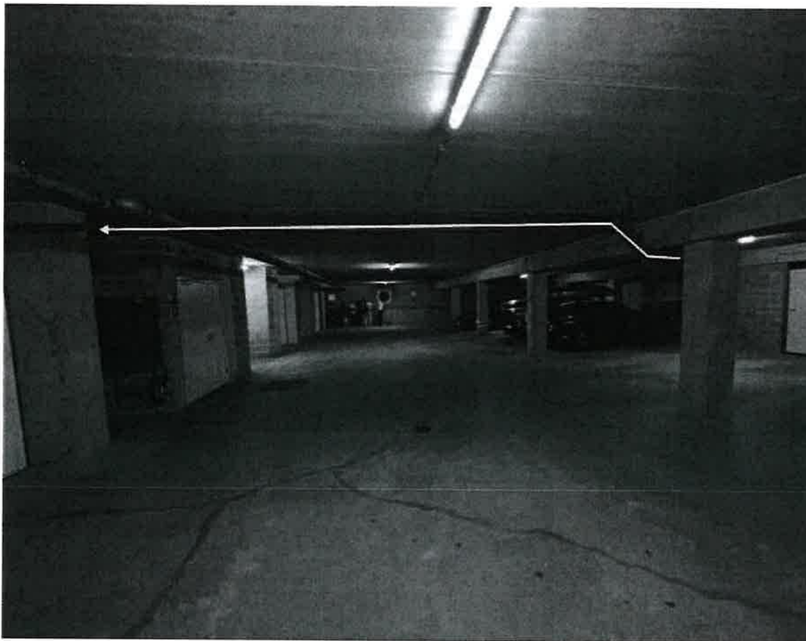
cheminement du câblage vers le n*13
