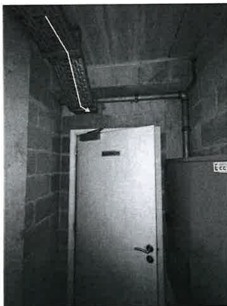
cheminement du câblage vers le n°13
