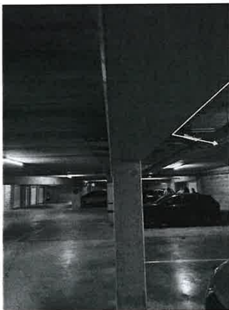
cheminement du câblage vers le n*13
