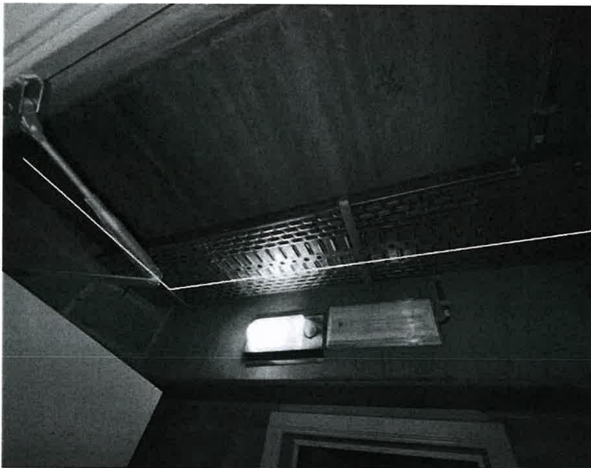
cheminement du câblage vers le n*13
