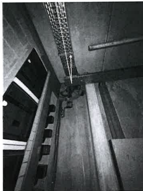
cheminement du câblage vers le n°13
